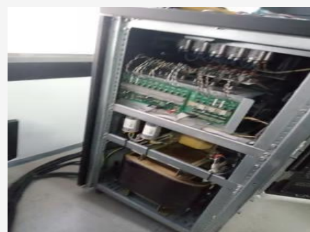
Vista interna del equipo
