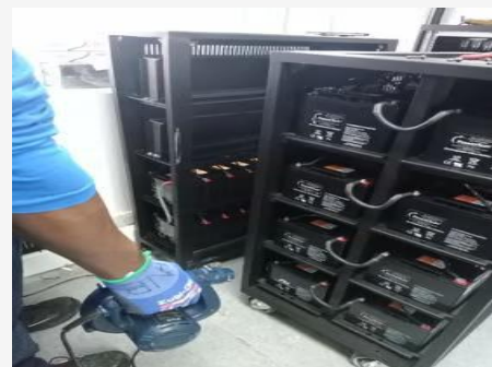
Durante el servicio — Inspección baterías
