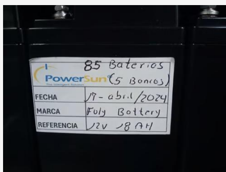
Verificación de baterías — Placa fecha
