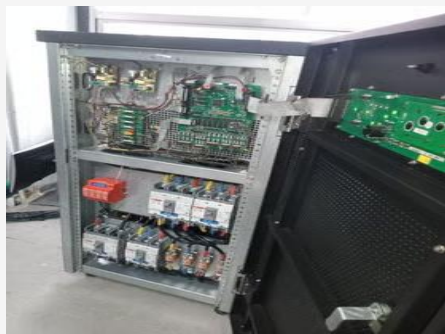
Equipo destapado — Después del servicio
